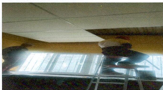
Foto 3: Sustitución de cielo falso dañado, por cielo falso nuevo.
