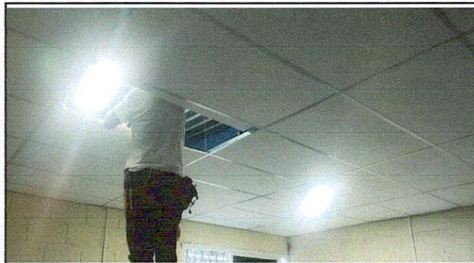
Foto 2: Sustitución de bombillas ahorradoras por lámparas LED
