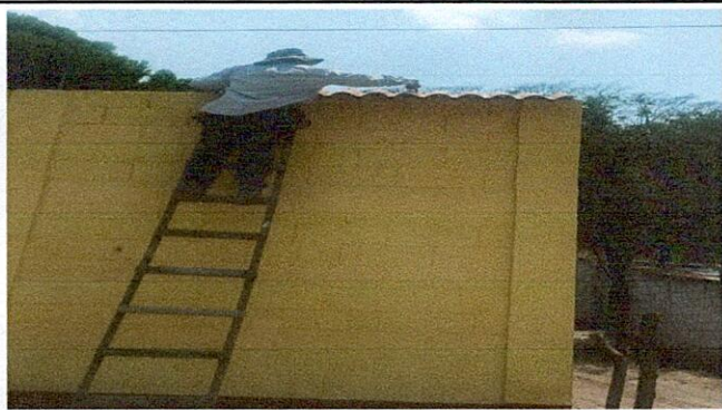
Foto 5: Sustitución de teja en mal estado, por teja nueva, en muro perimetral.
